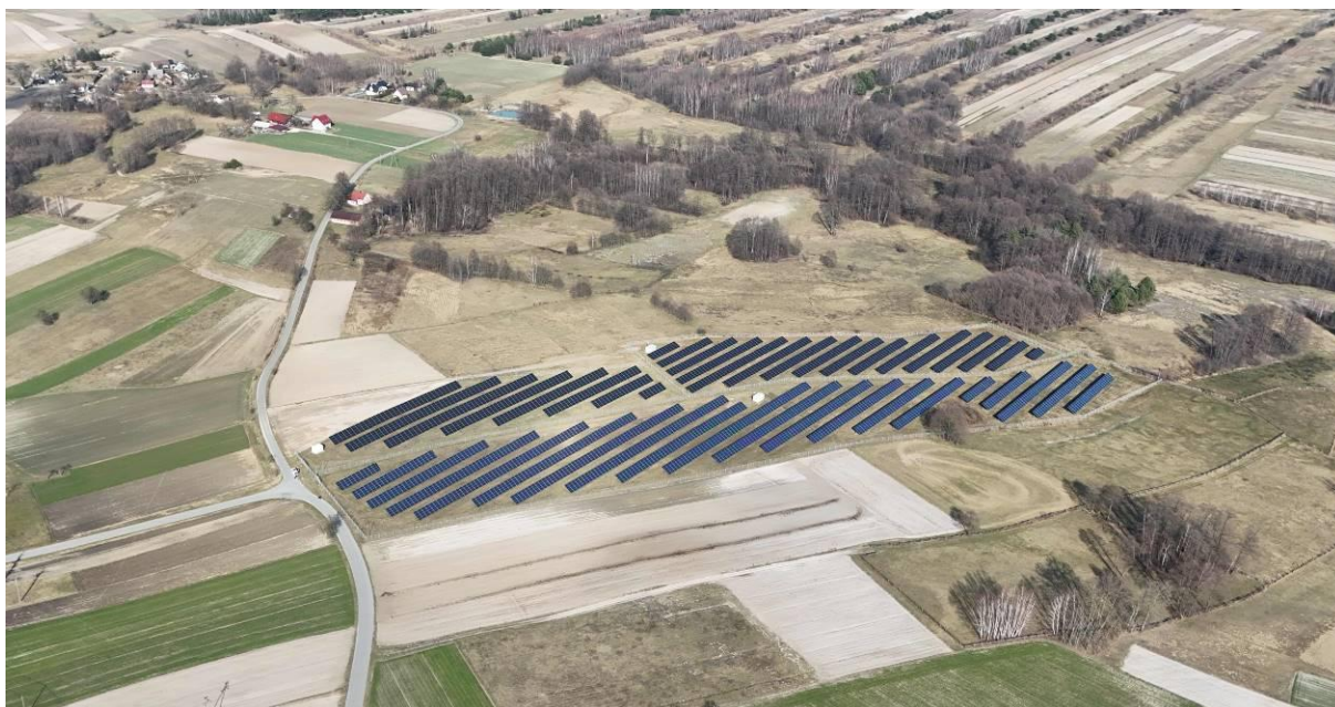
Fot. 12. Elektrownia fotowoltaiczna w obrębie ewidencyjnym Golce
